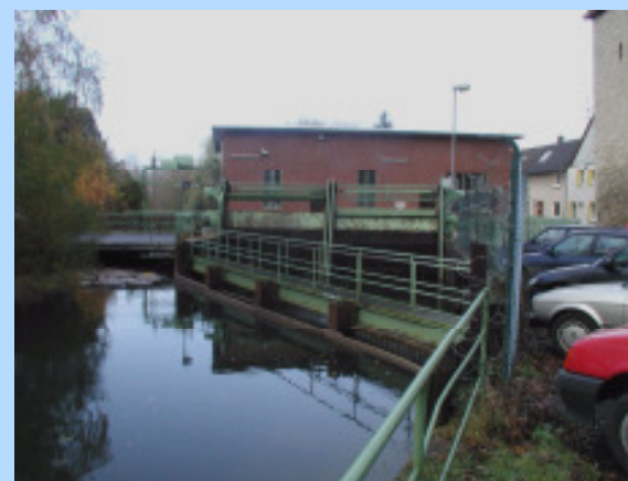
Wasserkraftwerk in Gronau (L.)
